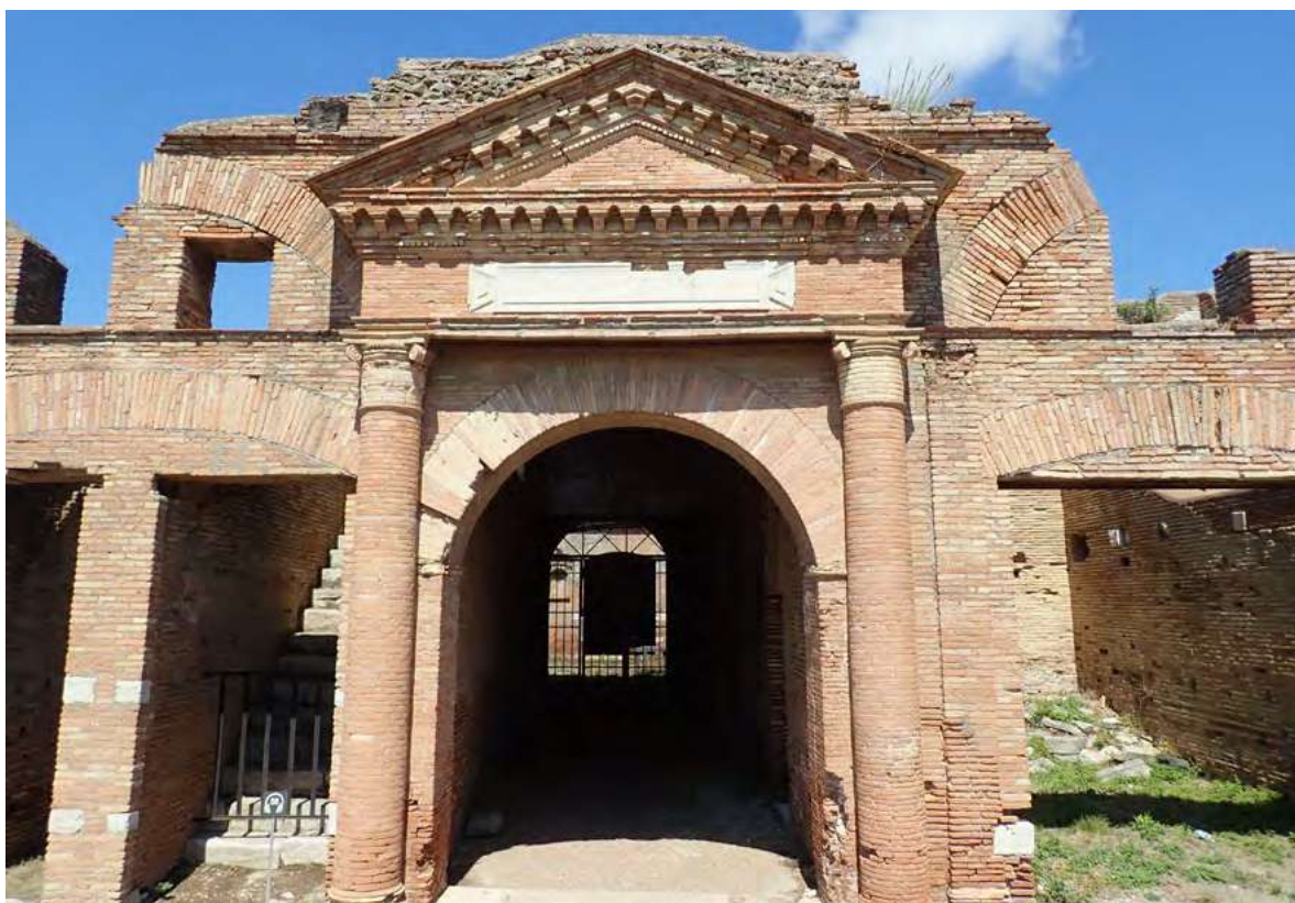
Obr. 69 Horrea Epagatiana v Ostii - opus testaceum . Foto: Miroslava Daňová.
