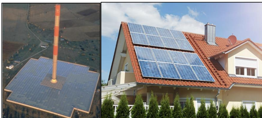
Obr. č. 59 Nepriama (vľavo) a priama (vpravo) výroba elektrickej energie zo slnka
