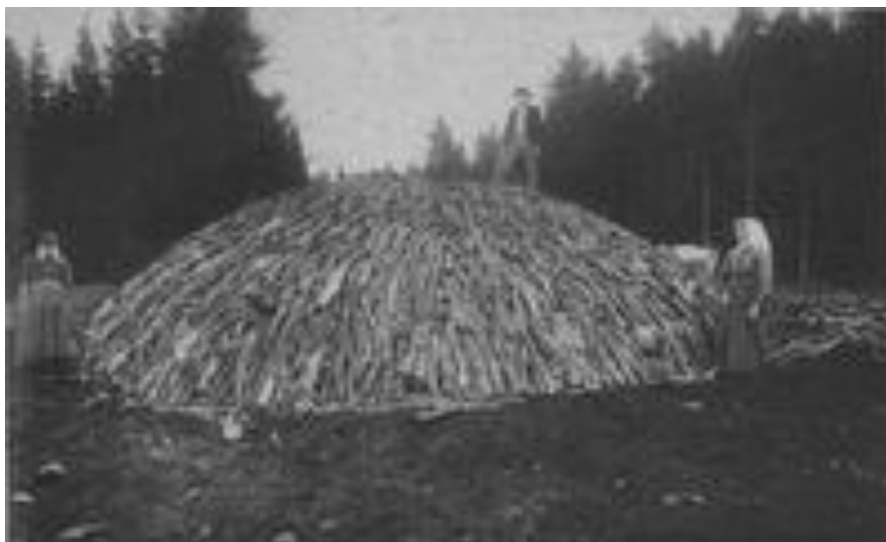
Obr. 4 Milier na výrobu drevného uhlia predtým, ako sa pokryje hlinou a začne sa vypaľovať (fotografia približne z roku 1890)
