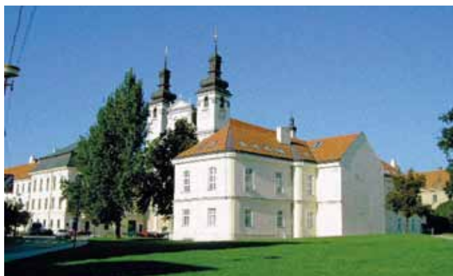
Budova FZaSP ešte pred výstavbou hotela Holiday Inn. Foto: Archív TU.
